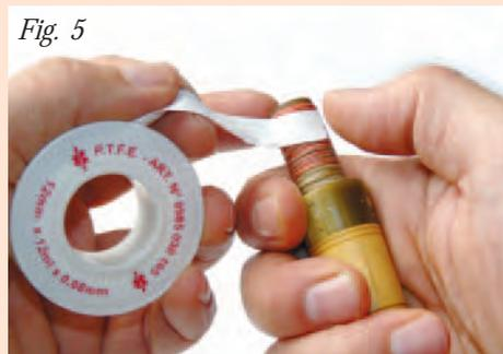
Le Téflon permet d'affiner les liaisons et facilite leur démontage. La cire d'abeille peut lui être substitué.
